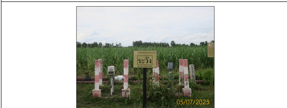
ภาพที่ 2.2-2 ป้ายเตือนแสดงขอบเขตแนวท่อก๊าซและพื้นที่วางท่อก๊าซของโครงการ
